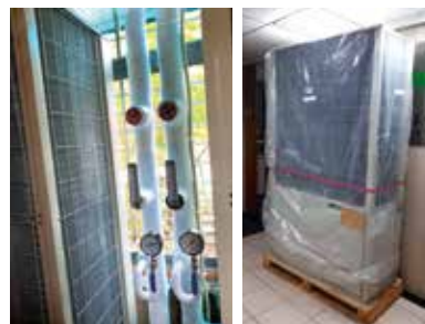
▲ 1樓冷氣主機更新工程
