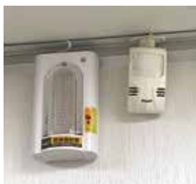
▲ 本會2、3樓消防改善施工
