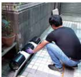
▲ 清洗本會冷氣設備
